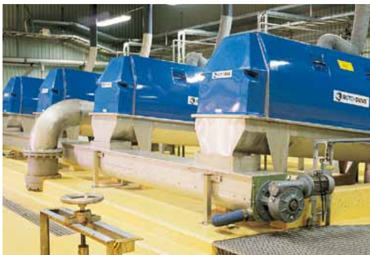
Installation av Roto-Sieve trumsilar modell RS-51 vid Kullaviks reningsverk i Kungsbacka.
